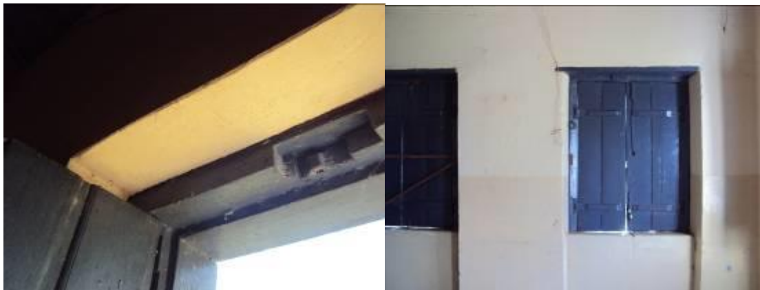
Figura 6: Espessura da Parede. Fonte: Suyanne Paranhos Matos, 2013.
