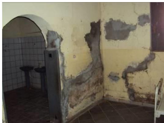
Figura 8 :Jardim da Fachada Sul e Umidade na Parede Externa. Fonte: Suyanne Paranhos Matos, 2013.
