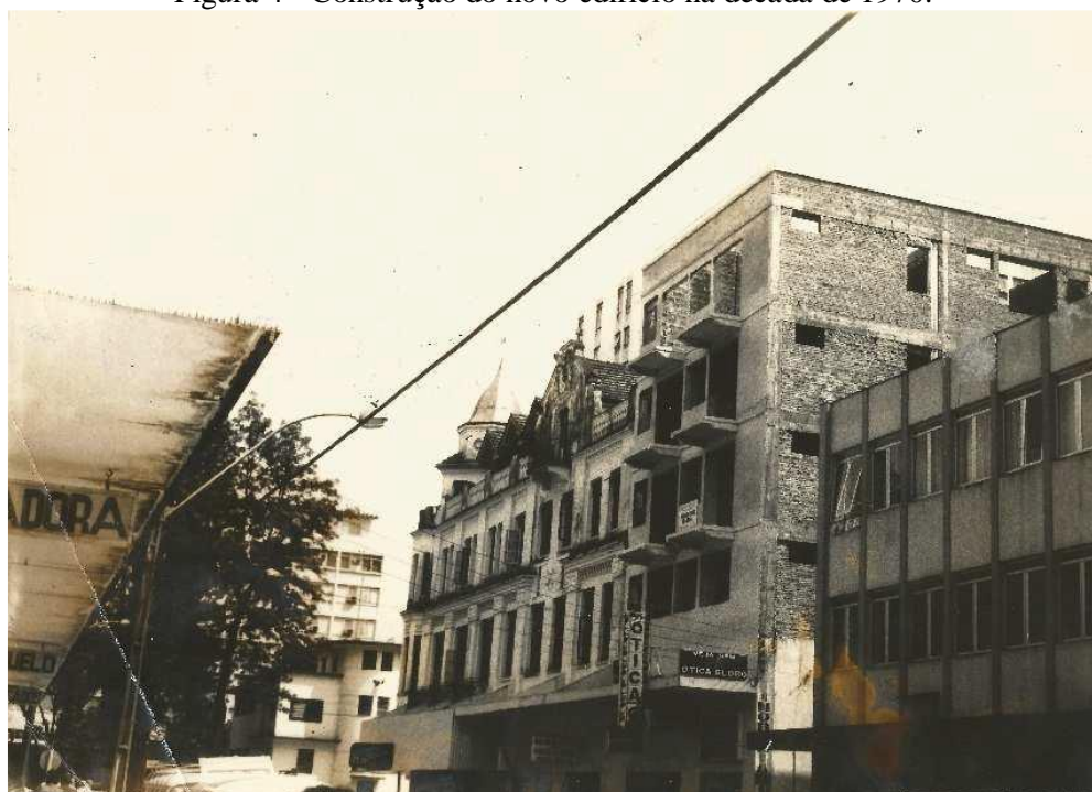
Figura 4 - Construção do novo edifício na década de 1970.
