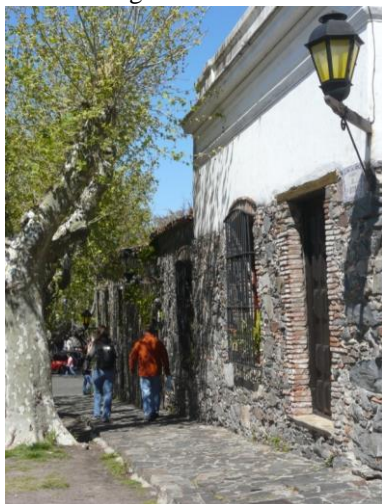
Fotografía 6: Fachada de una vivienda privada, piedra a la vista. Fotografía de la autora
